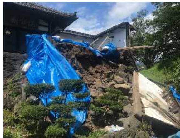
重要文化財 小諸城三之門 (長野県小諸市) 令和2年7月豪雨による塀の崩壊
