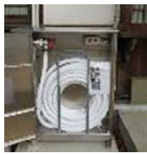
(易操作性1号消火栓)
