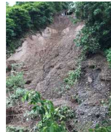
史跡 人吉城跡 (熊本県人吉市) 令和2年7月豪雨による土砂崩れ
