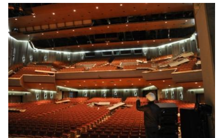
天井が落下するなど、甚大な災害を受けた文化施設（福島県文化センター）
