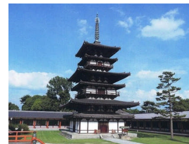
国宝薬師寺東塔保存修理 (奈良県奈良市)
