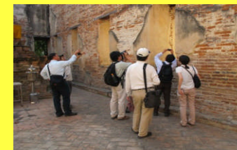
タイ・アユタヤ遺跡洪水被害状況調査
