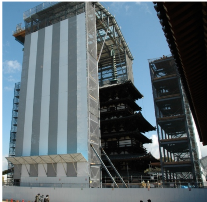
解体修理 仮設設置 薬師寺東塔(奈良県)
