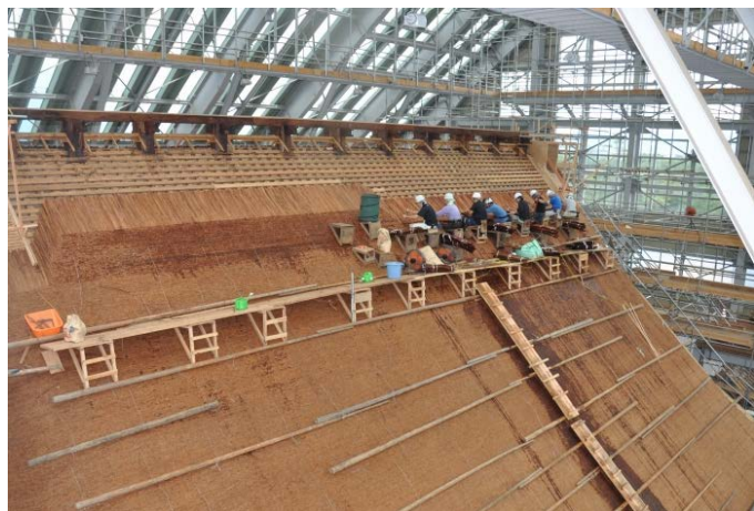
屋根葺替 檜皮葺 出雲大社本殿(島根県)
