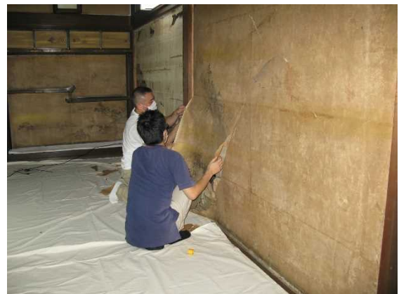
障壁画修理の様子
