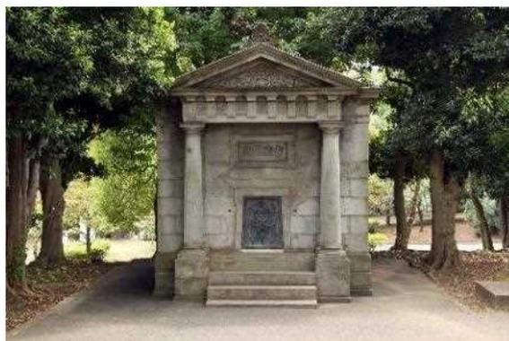
原点は地下約10メートルの安定地盤から基礎を築き、花崗岩の台石に水晶板をはめ込んで表示する。掩蓋は原点を保護する上屋で、原点とは独立した構造をもつ。工部大学校造家学科一期生の佐立七次郎の設計による古典様式の記念碑的な建物である。
