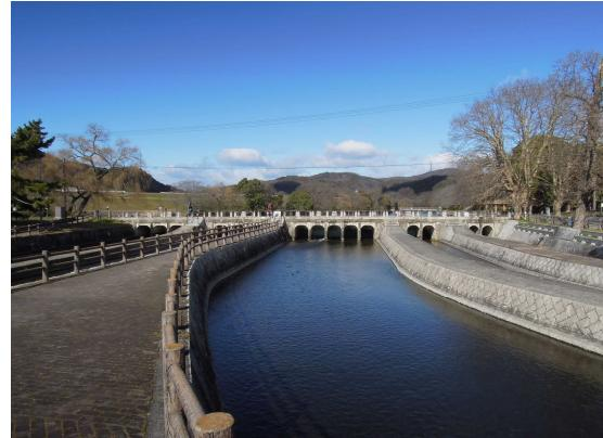
高梁川東西用水取配水施設は、近世以来の小規模な取水施設を統合して、合理化と大規模化が図られた近代農業用水施設のうち、大正期における最大規模のものとして重要である。また大正期に全国的に導入が進められた鉄筋コンクリート造樋門の現存例としても貴重で、農業土木技術史上、価値が高い。
