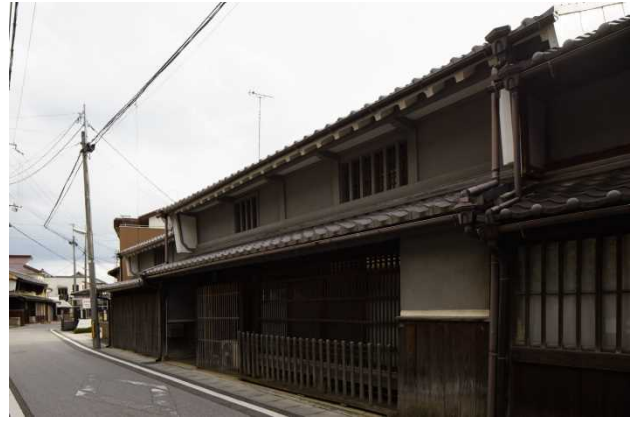
保存地区の伝統的な町家 虫籠窓や袖うだつを持つ古い形式の町家
