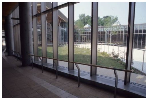
写真1 ガラス面に沿って設置された手すりと誘導用床材
