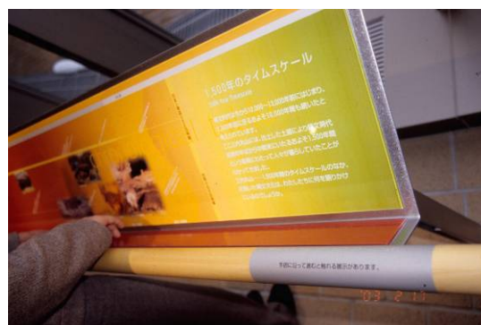
写真3 手すりに沿って展示面との間に施されている点字の解説、及び手すりに貼付された墨字と点字を施したシート
