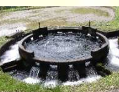
音無井路12号分水
