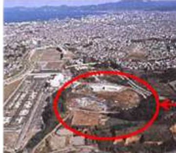
建設途中の 野球場
