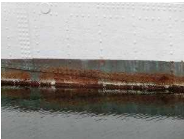
外板塗装の剥離と鋼鉄の錆の進行 重文・日本丸(神奈川)
