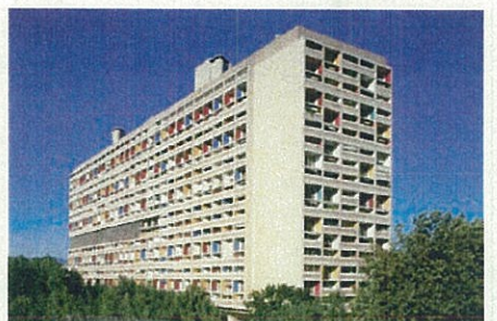
UNITÉ D'HABITATION 1945 Marseille, France
