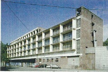
USINE CLAUDE ET DUVAL 1946 Saint-Dié, France
