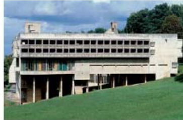
ラ・トゥーレットの修道院(フランス)
