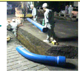
ポリエチレン管の布設
