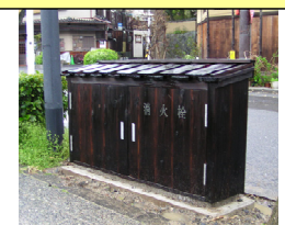
耐震性が確保された消火栓
