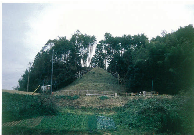
墳丘応急対策後（南から）
