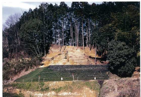
南側斜面応急対策後（南から）
