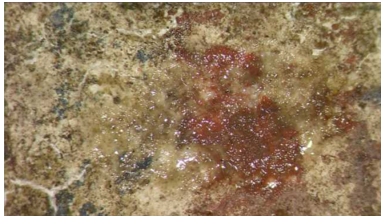
写真 17 水処置により亀裂がふさがる
