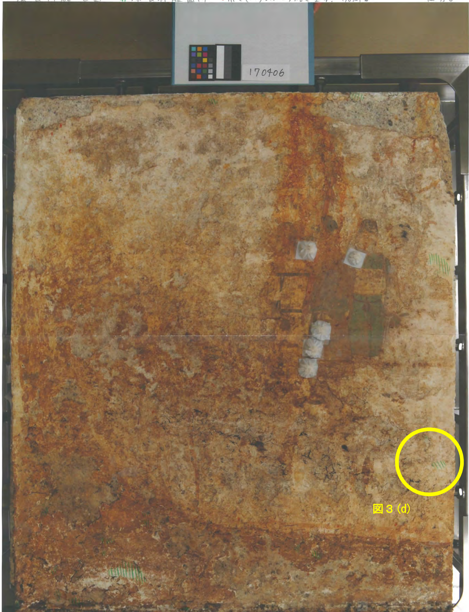
図5 しっくいのはらきに関する損傷マップ
