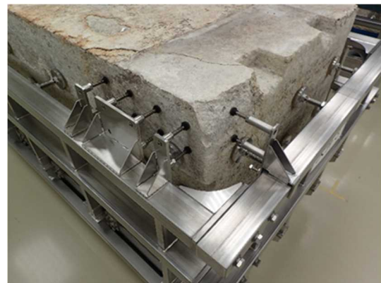
図3 金属製治具による天井石の固定
