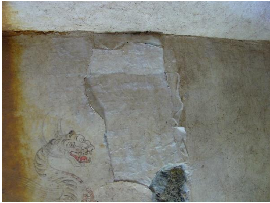
図1 取り外し前の養生（西壁白虎）
