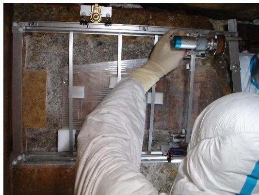
図4 ダイヤモンドワイヤーソーによる朱雀の取り外し
