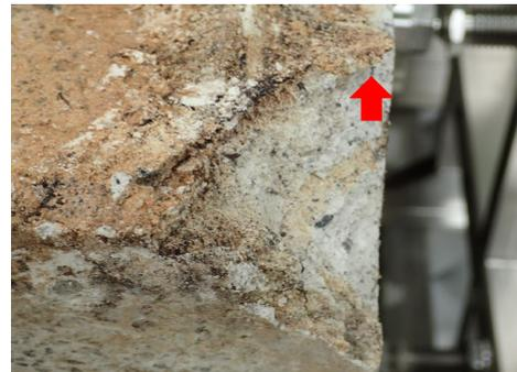
写真4 東男子 充填補強箇所
