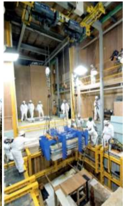
石材取り上げ作業の様子
