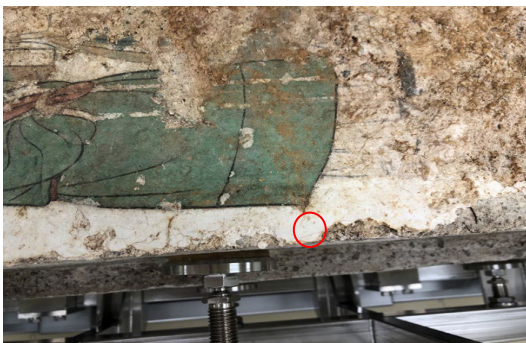
写真3 状態確認箇所 東男子 解体時 HPC 養生
