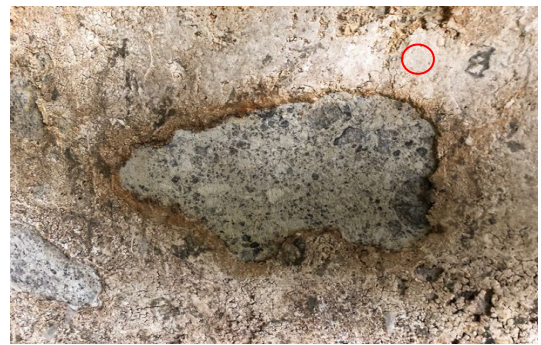
写真2 状態確認箇所 天井3 解体時 MC 噴霧
