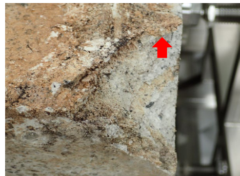
写真4 状態確認箇所 東男子 充填補強
