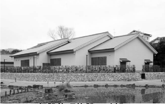
仮設修理施設の外観
