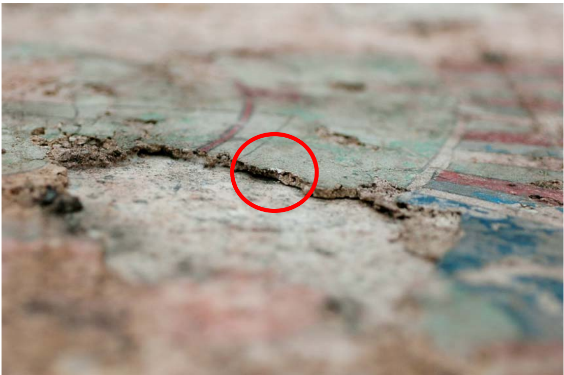
東壁女子群像：損傷後断面拡大（平成20年12月8日撮影）
