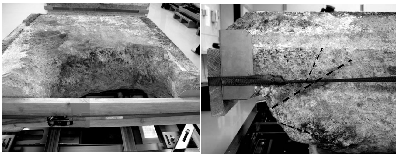
図 I-10. 保存修理施設で保管されている状態。石材を取り上げたときの、ベルトで拘束した状態になっているが、ベルトは一時的なもので、緩んでくると石材の自重でブロック状に崩落する危険がある。
