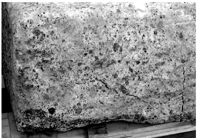
図 1.6. 床石 4 の西側面に発生している亀裂
