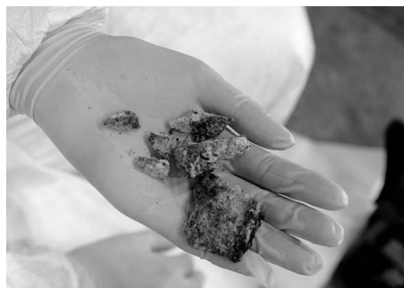
図 1.2. 取り外された石材（内部では、石材は破碎され多数の小片に遊離していた）
