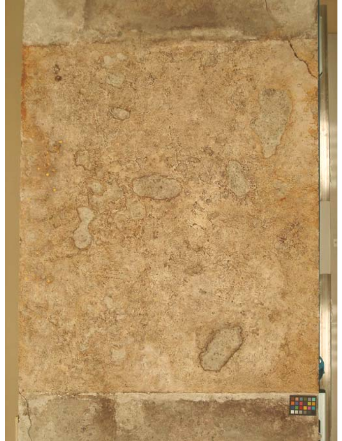
天井3 クリーニング作業後
