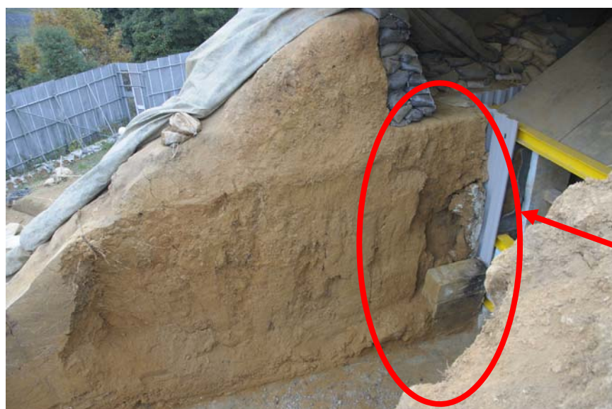
2階部分撤去後の状況(11/28)
