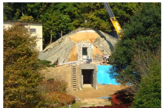
旧保存施設撤去工事の状況(平成20年11月)
