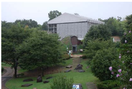
石室解体中の墳丘周辺の状況(平成19年7月)
