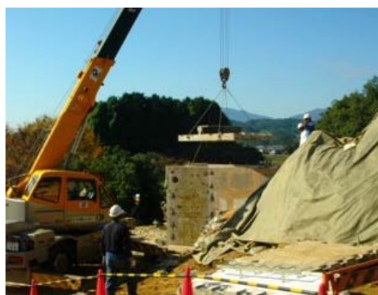
クレーンでPCを吊り上げる(11/14)
