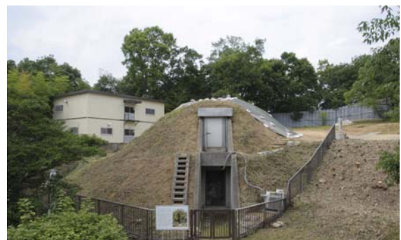
墳丘上の仮設覆屋を撤去した状況(平成20年6月)
