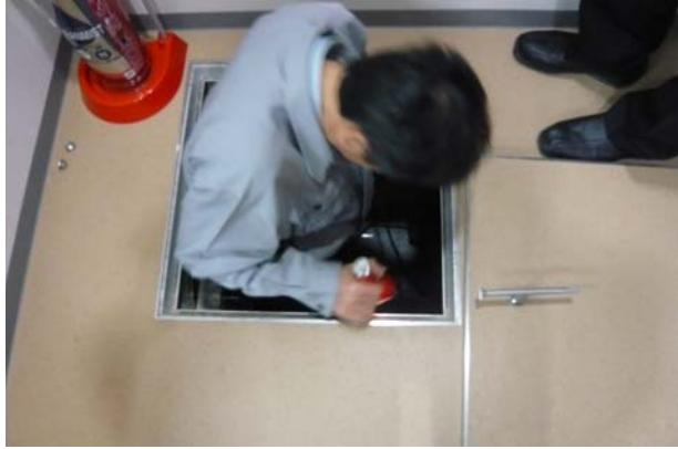
地下ピットの調査（見学通路床面より）
