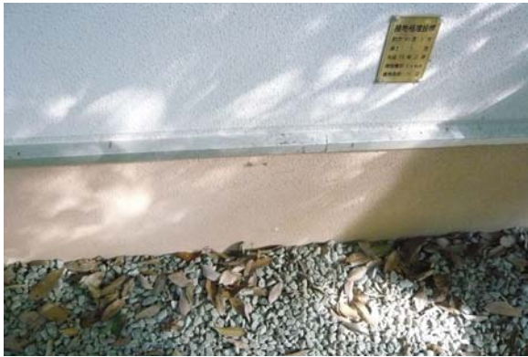
建物外周外壁の継ぎ目
