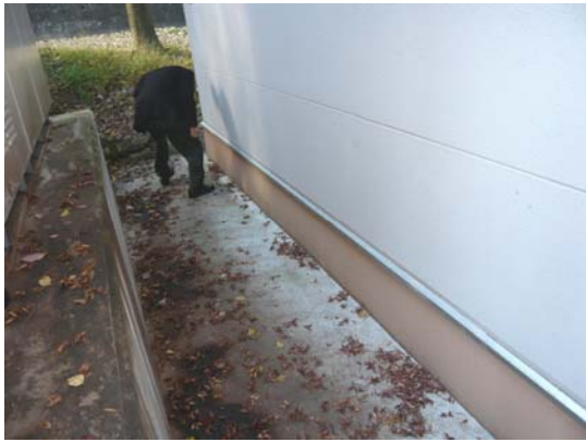
建物外周の状況（修理作業室側）
