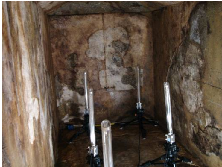
殺菌灯を設置した石室内の状況
