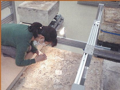
修理作業の様子
