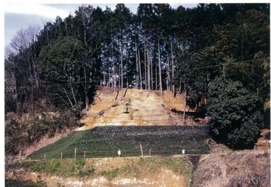
南側斜面応急対策後(南から)
