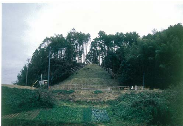
墳丘応急対策後(南から)
