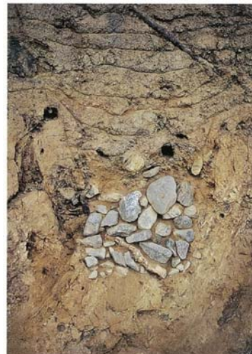
南側斜面 暗渠排水溝(南から)
