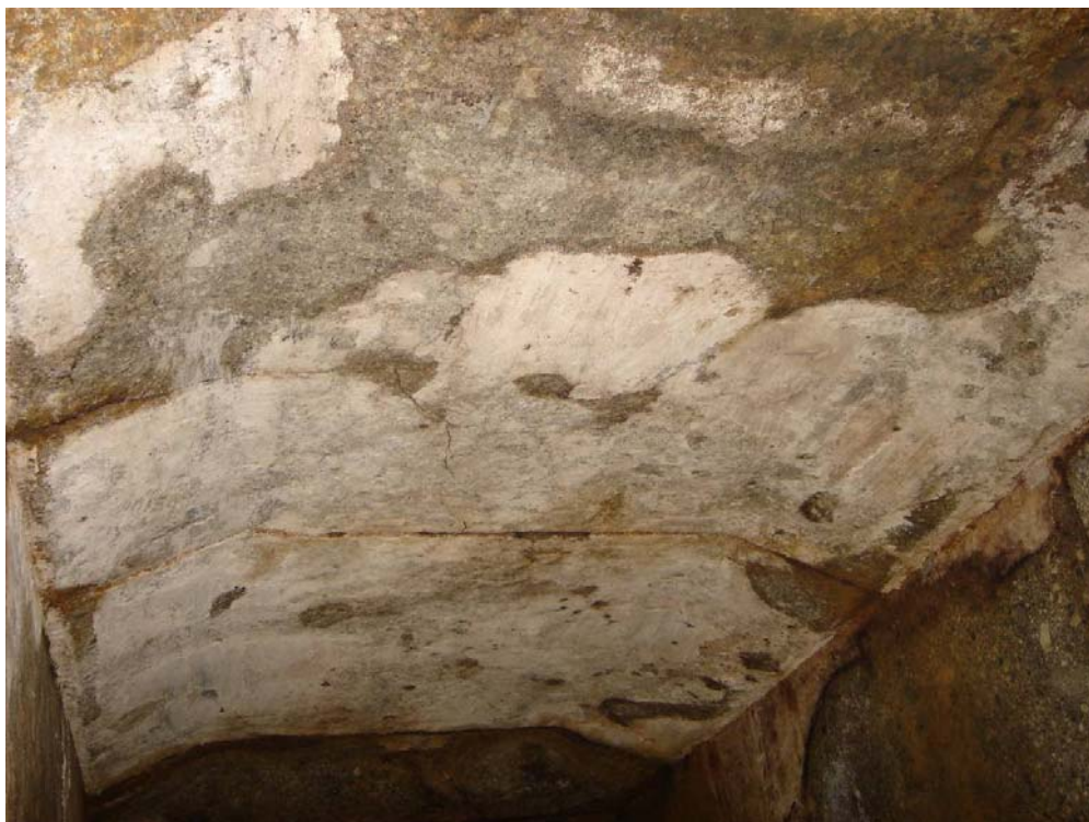
天井取り外し終了後
