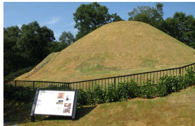
再施工後の状況
