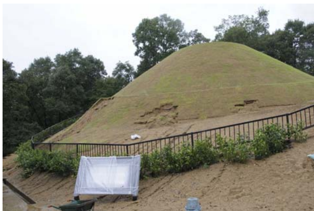
高松塚古墳における崩落の状況
