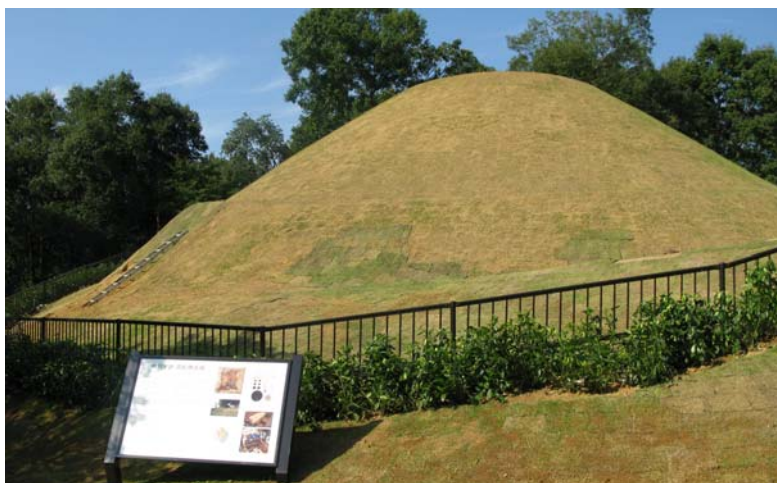
仮整備後の高松塚古墳
