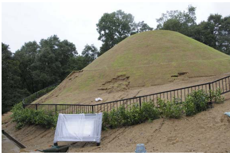
高松塚古墳における崩落の状況
