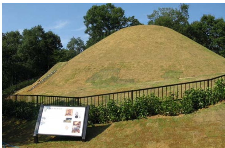
崩落箇所の現在の状況
