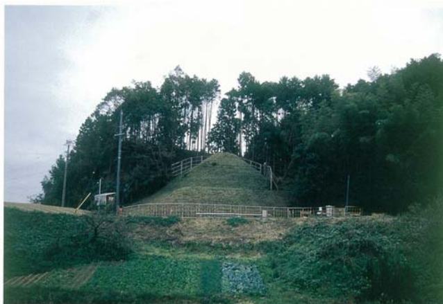
墳丘応急対策後(南から)
