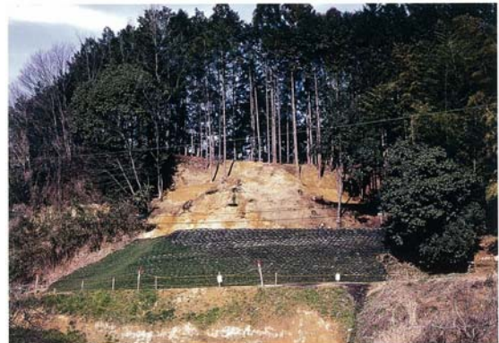
南側斜面応急対策後(南から)
