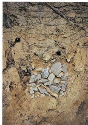
南側斜面 暗渠排水溝(南から)
