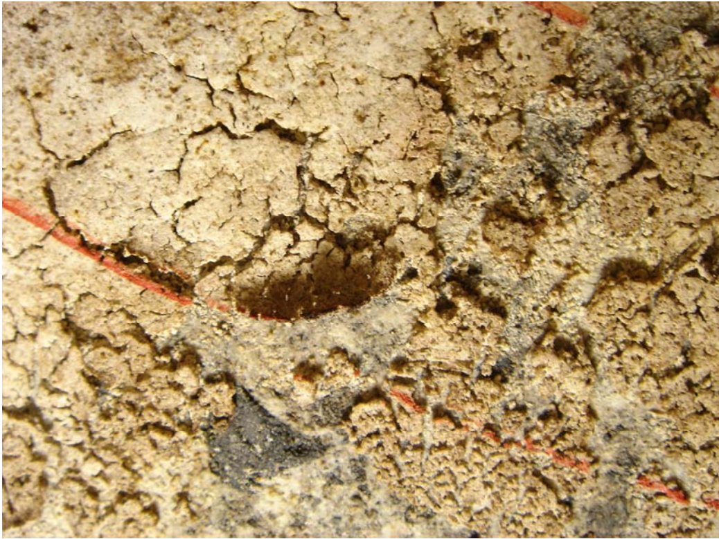
天井天文図落下危険箇所（剥ぎ取り後）
