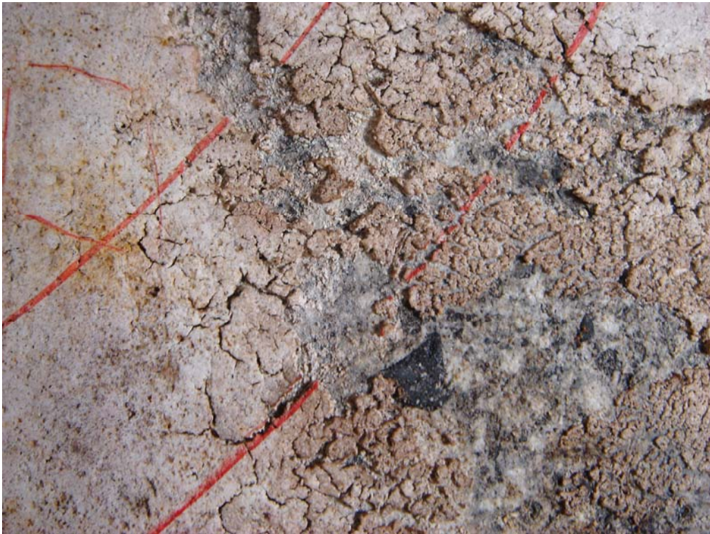
天井天文図落下危険箇所（剥ぎ取り後）
