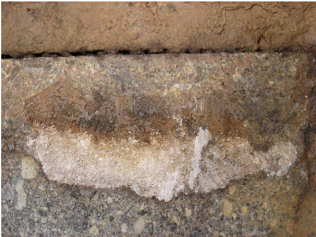
天井余白部分（南側）剥ぎ取り後
