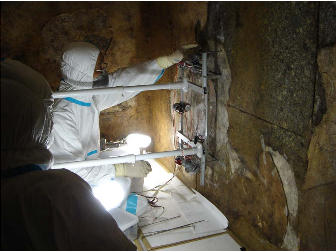
側壁余白部分の剥ぎ取り作業
