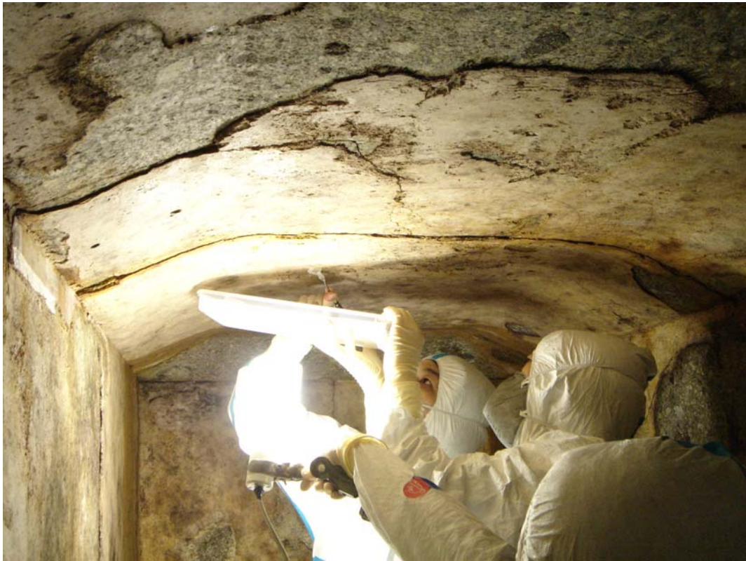
天井の剥ぎ取り作業（天井天文図危険箇所）
