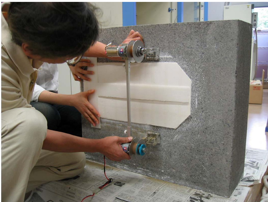
ダイヤモンドワイヤー・ソー使用状況（垂直面の場合）
