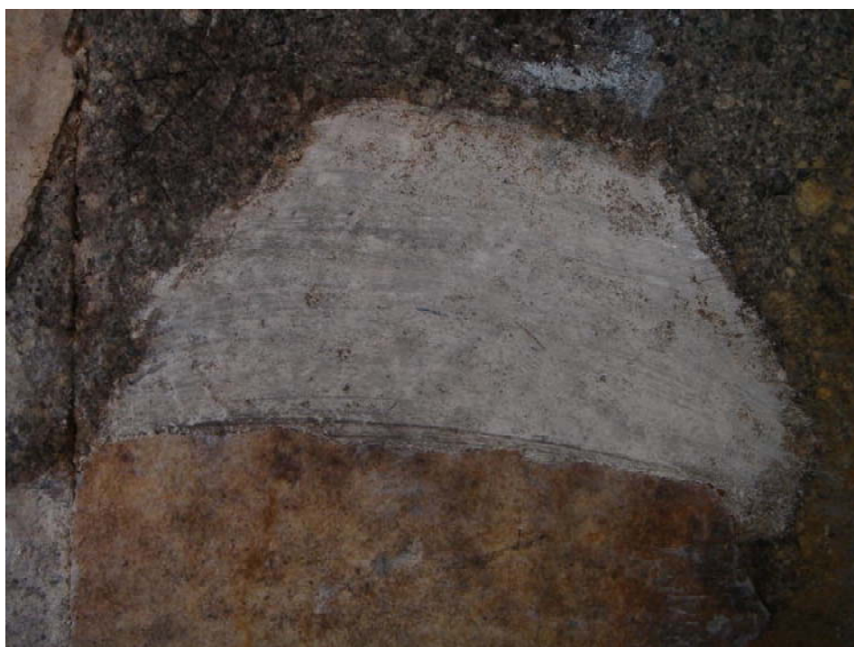
寅斜め上の箇所の剥ぎ取り作業後
