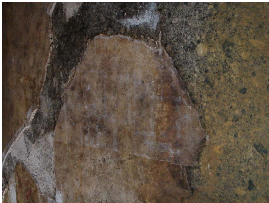
寅斜め上の箇所の剥ぎ取り作業前
