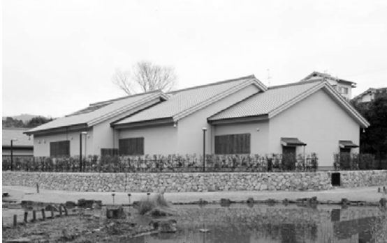
仮設修理施設の外観
