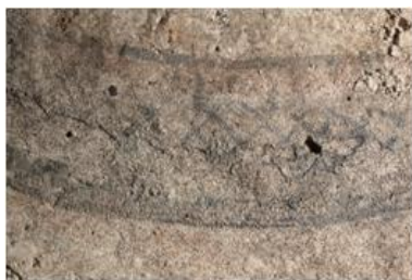
写真6 緑色顔料の消失が著しい箇所
