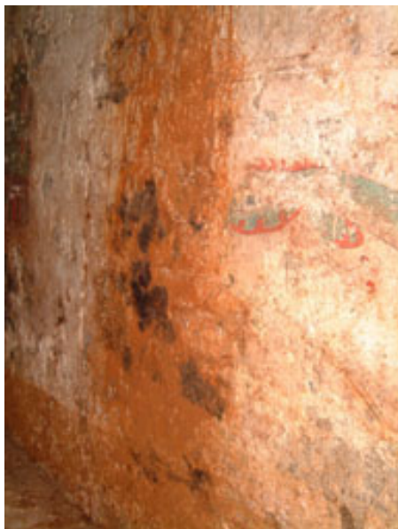
写真 1 - 3 青龍の黒色カビ発生状況 (平成 14 年 10 月)
