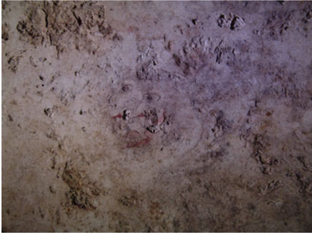
写真 2 - 5 漆喰層内部が中空化し、陥没
