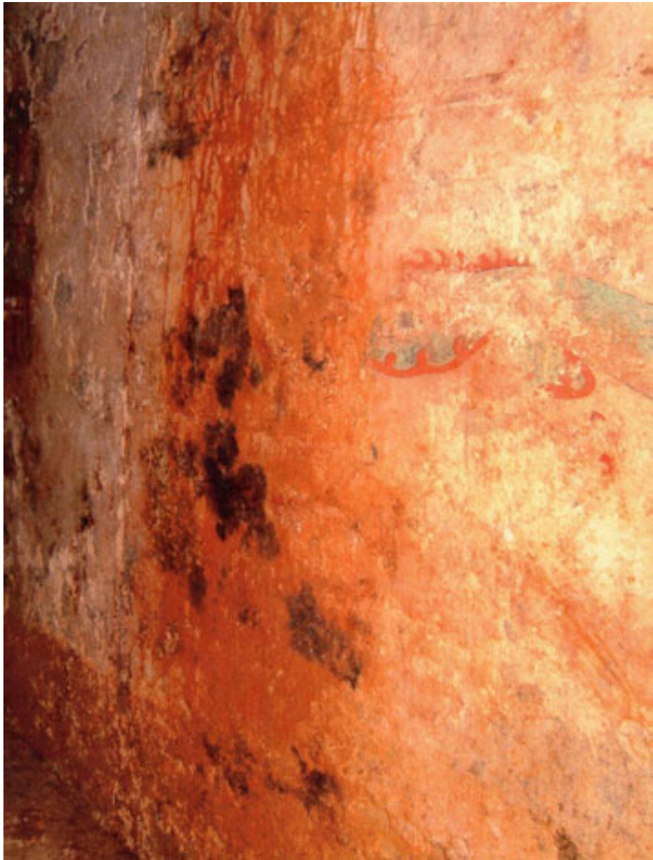
写真 5. 2002 年 10 月 28-30 日の点検時に東壁の青龍付近にみられた黒色の汚れ
