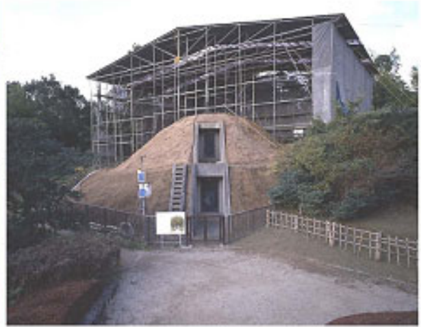
第2図 調査用覆屋の建設風景
