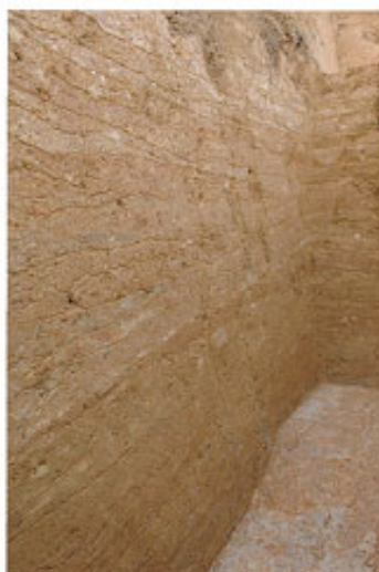
手前から 亀裂⑮、⑯、⑰
