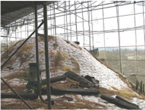
第3図 シート下の土囊の積み上げ状態
