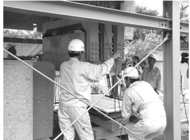
図2. 第1実験場で実施された天井石(南1)の吊り上げ・移動・梱包・回転に関する実験
