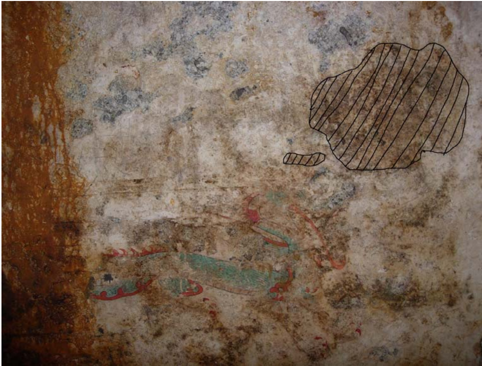
青龍（斜線が当該部分） 平成 17 年 9 月 6 日撮影
