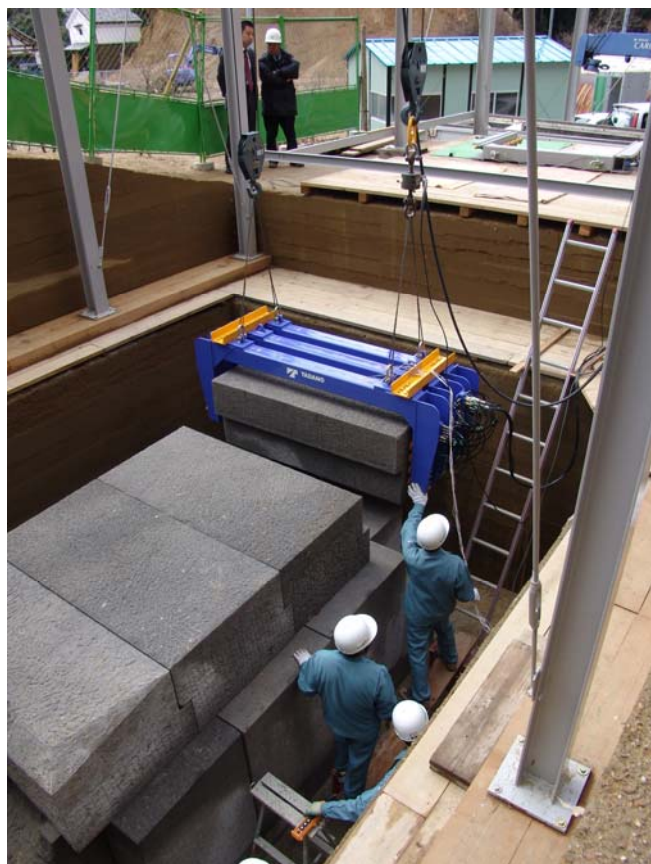
図7. 第二実験場における第三世代門型治具を用いた天井石吊り上げ実験
