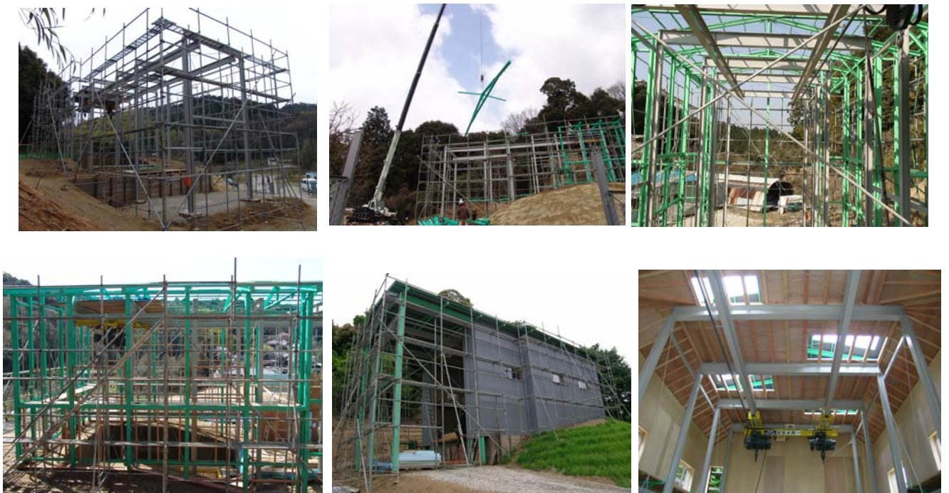
図 12. 環境制御のための内部覆屋の実験に向けた準備過程の写真
