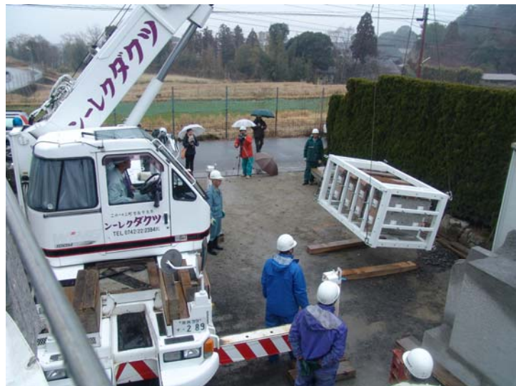
図 6. 天井石の梱包のための特殊フレームの開発実験
