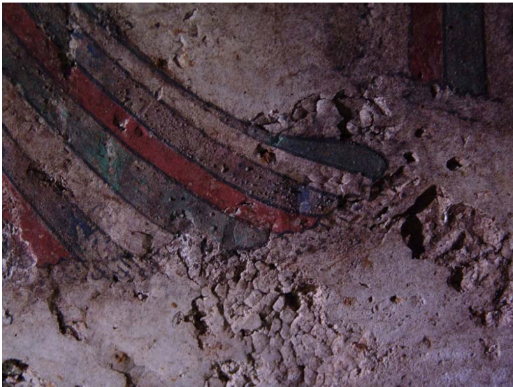
写真 2 - 4 漆喰層内部が中空化し、表層を支えられず陥没している また、中央部に白濁した樹脂が見られる
