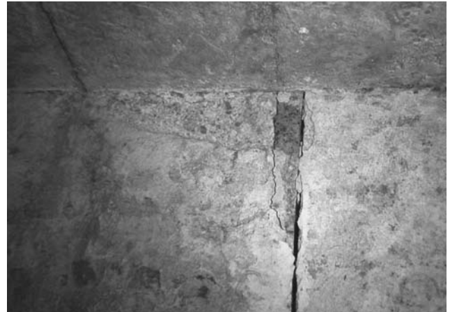
図 1.11 西壁 1（南壁石側）の上部北端に見られる細長いブロック状の割れ。ほぼ遊離した状態にあると観察される。
