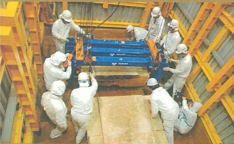
13. 床石の吊り上げ
