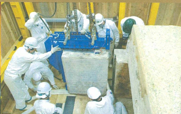
6. Γ（ガンマ）型治具による壁石の吊り上げ
