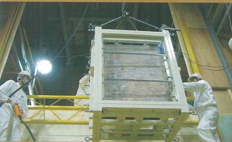
7. 壁石はフレームに梱包して移動
