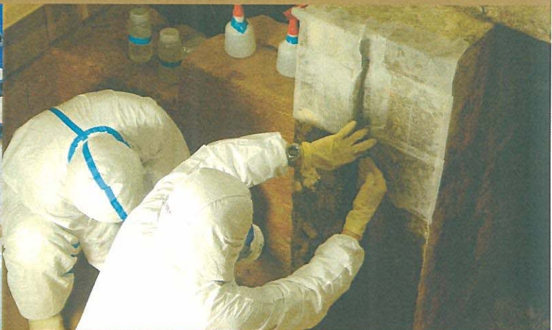
12. 新たに露出した箇所の殺菌処置
