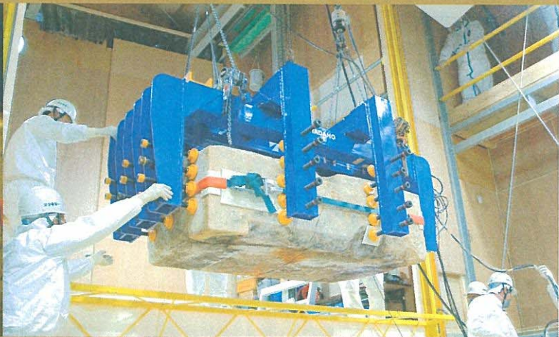
10. オクトパス型治具による天井石の吊り上げ
