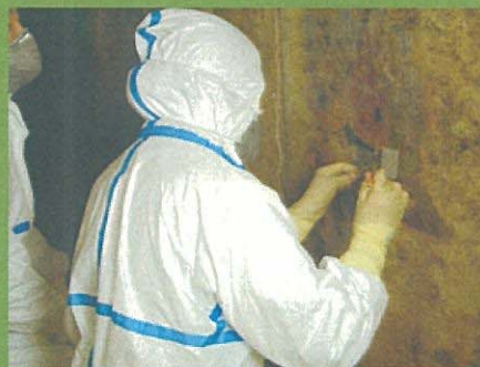
石室内での養生作業▶
