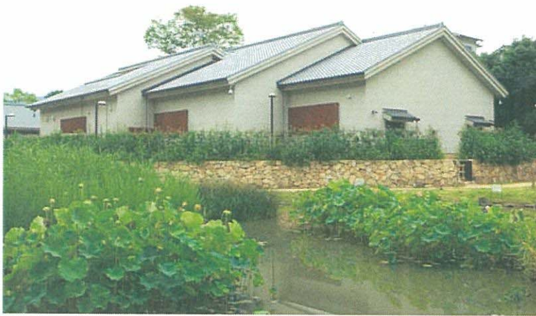
仮設修理施設の外観
