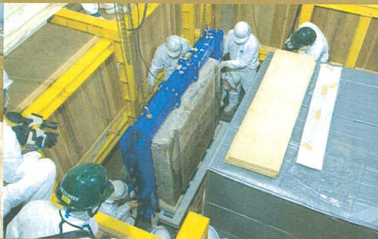
2. Π（パイ）型治具による北壁の吊り上げ（中央に玄武）
